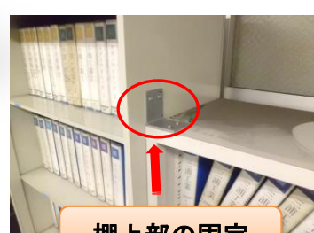
棚上部の固定
